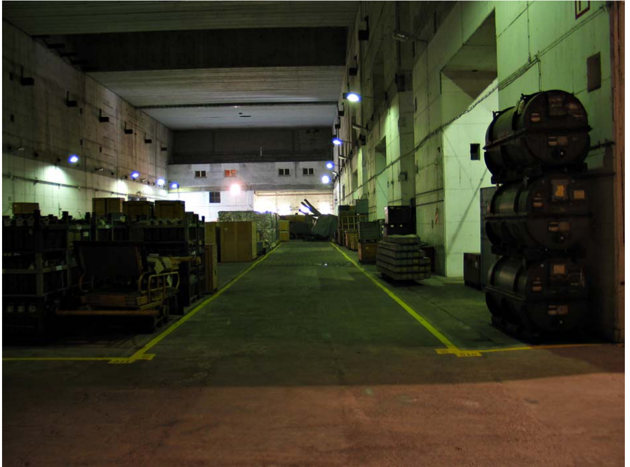
Bild 2: Zum Zeitpunkt der Aufnahme noch genutztes Lager im in den 1960er Jahren renovierten Teil des Bunkers, Oktober 2006 (Photo: Bastian Spille).
