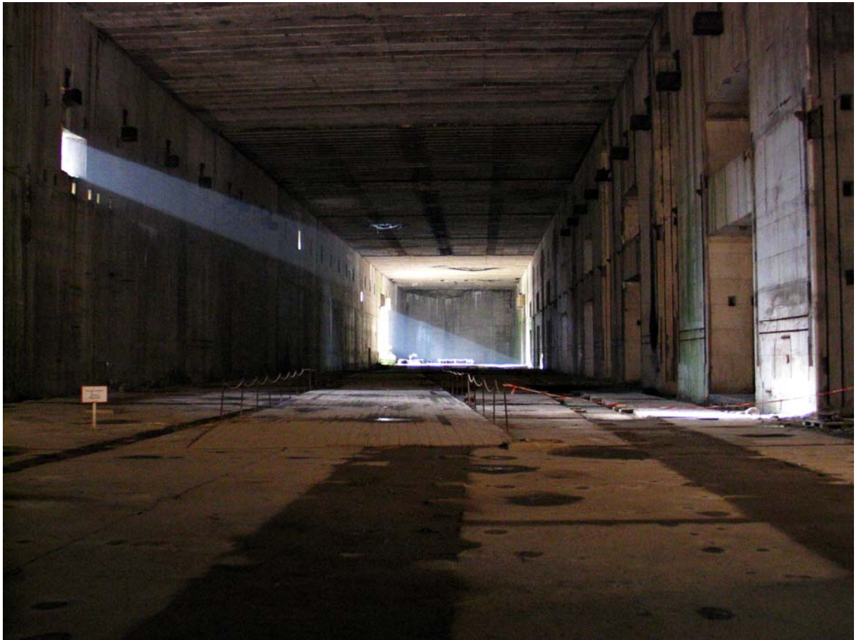
Bild 1: Innenansicht des Ruinenteils des Bunkers „Valentin“, Oktober 2006 (Photo: Bastian Spille).
